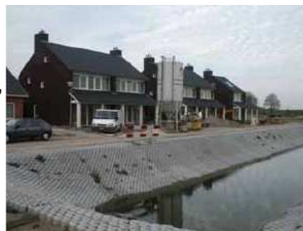
Figuur 4.6: aanleg waterpartij Kwelderland
