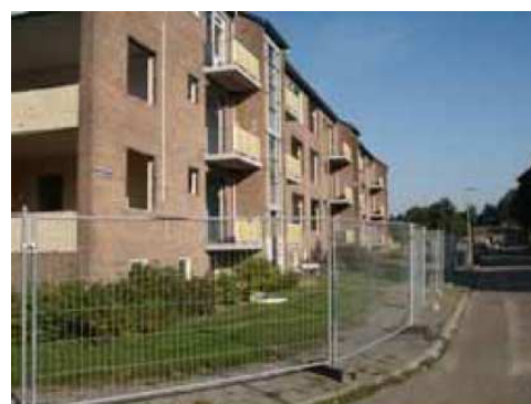
Figuur 4.3: afbreken portiekflats in Noord
