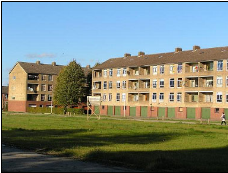
afbeelding 3.1: portiekflats in Paddepoel-Zuid; een onaantrekkelijke woningvoorraad
