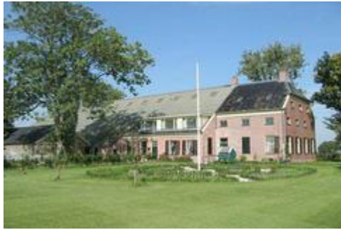
Foto 6.1 Verbouwde boerderij, Scheemderzwaag 16, Scheemda 54
