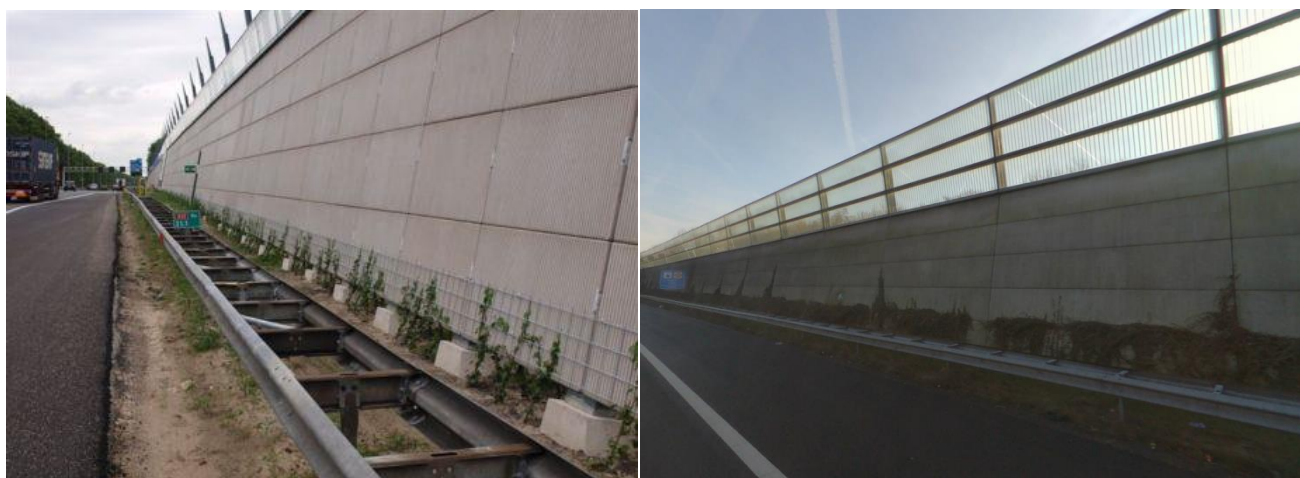
Figuur 27: Geluidsscherm tussen Woerden en Gouda langs de A12 (Bron: ingenieursbureau M.U.C. & Cyclomedia)
