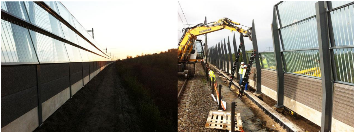
Figuur 18: Mooie zijde van geluidsscherm richting beschermde kant/frame aan binnenkant. (Bron: Fabrique3d)
