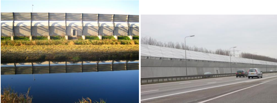
Figuur 17: Verschil voor- en achterzijde geluidsscherm A2 ter hoogte van Maarssen. (Bron: Van Campen)
