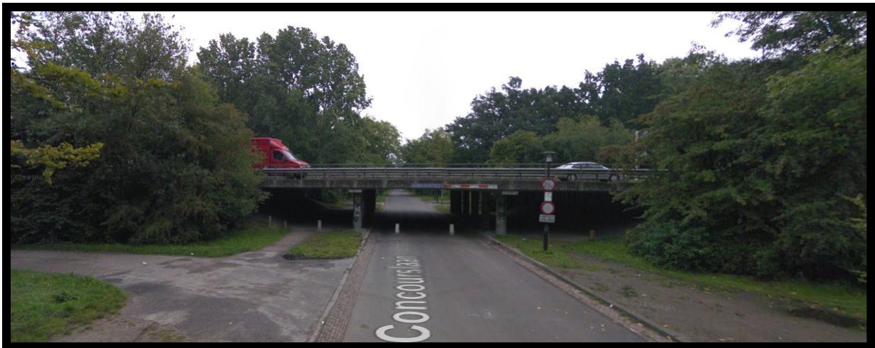
Figuur 9: Het viaduct bij de Concourslaan (Google Streetview, 2013)
