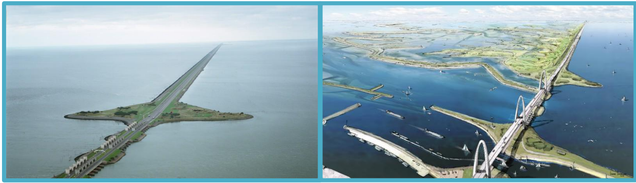
Figuur 27 – Links, de afsluitdijk in haar huidige vorm.
