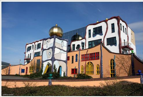
Figuur 12. Bedrijfspand Aan de Stegge Gooor
