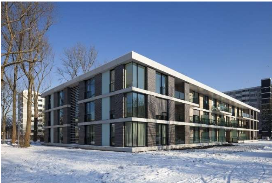
Figuur 5.4 Zelfstandige appartementen met zorg De Peelhorst (bron: A&E Architecten, 2013)
