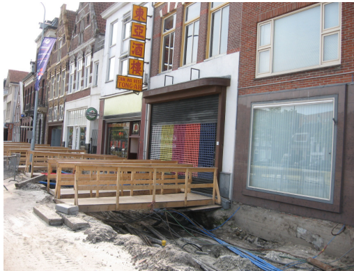
Figuur 30: het Damsterdiep tijdens het bouwproject (door: Koos)
