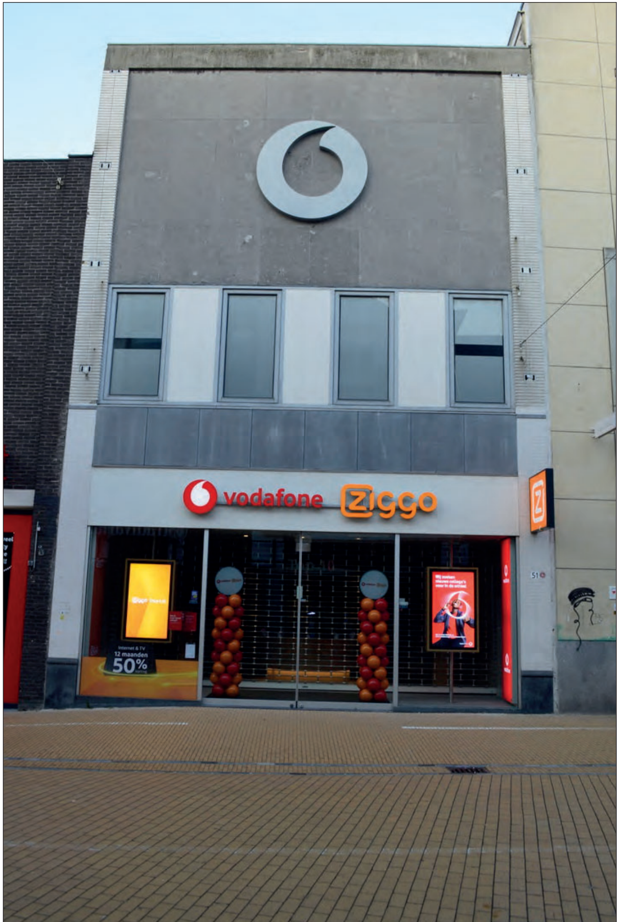
Herestraat 51: Vodafone, Ziggo
