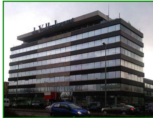
Foto 6; Broedplaats voormalig Volkskrantgebouw.
