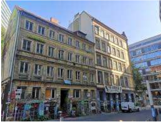
Figure 4: Speckhaus before renovation 2021 / Verein Gängeviertel e.V. (2021)
