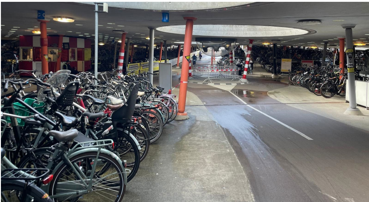
Figure 6 - Stadsbalkon Bicycle Parking, Groningen Hoofdstation (Hausmann, 2024)
