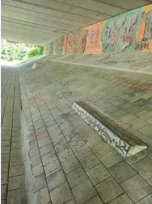
Figure 28: Driebondsbrug slappy curb (Author, 2024)
