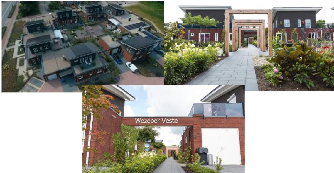
Figuur 4 - Foto's van Wezeper Veste in Wezep. Hierin zijn een bovenaanzicht, voorkant en binnentuin te zien.
