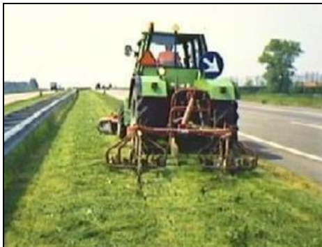
Figuur 14. Werkzaamheden in de wegberm. (Bron: Rijkswaterstaat beeldbank)
