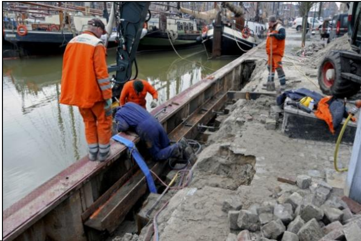
Figuur 13. Werkzaamheden bij damwand Harlingen. (Bron: Leeuwarder Courant, 2010)
