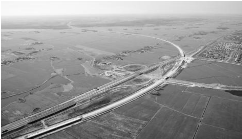
Figuur 6.3: Hanzelijn in aanbouw en Rijksweg A50 (Sokolewicz et al, 2011;p. 9)
