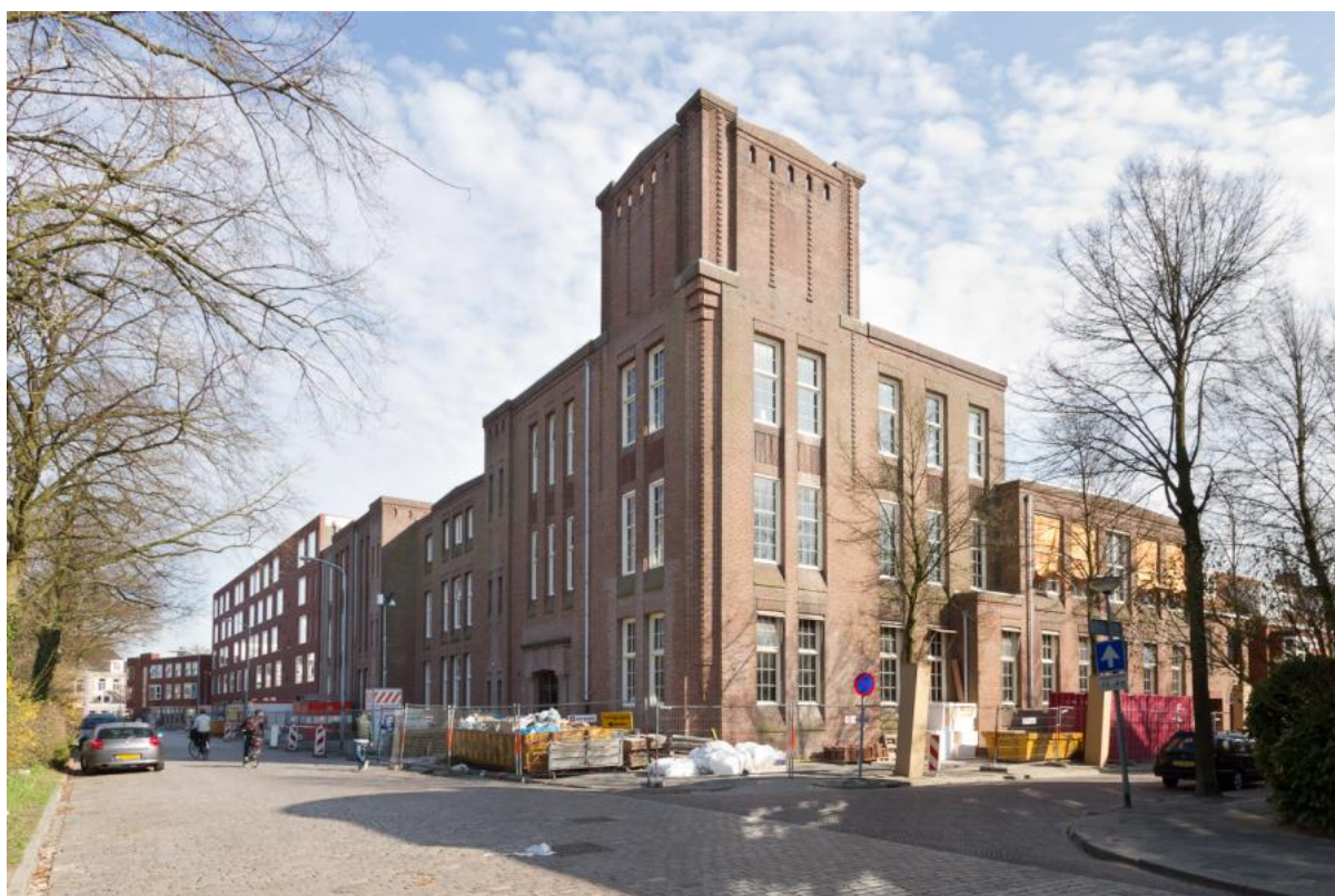
Foto 1. Voormalig Belastingdienstkantoor aan de Dr. C. Hofstede de Grootkade 11 te Groningen ( http://www.staatingroningen.nl/2578/jongerenhuisvesting-hofstede-de-grootkade )
