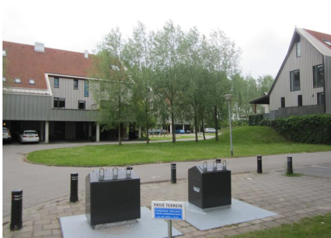
Figuur 5.03: De Verandawoningen langs de Kapitein Wal Ruslaan, gezien vanaf de zuidelijke inrit naar de buurt. De glas- en papiercontainers zijn ingegraven en aan de rand van de buurt geplaatst. Op het bordje op de voorgrond staat 'verboden toegang art. 461'.
