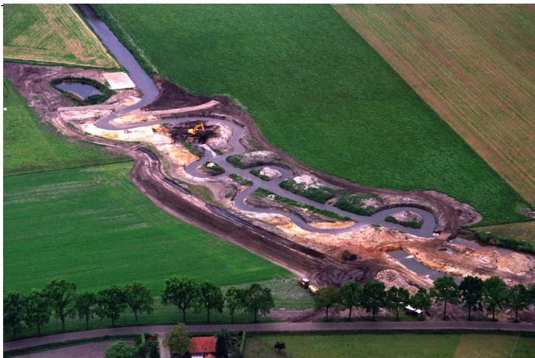
Afb. 1-1. Luchtfoto beekherstel Groote Beerze Bron: website waterschap De Dommel, www.dommel.nl
