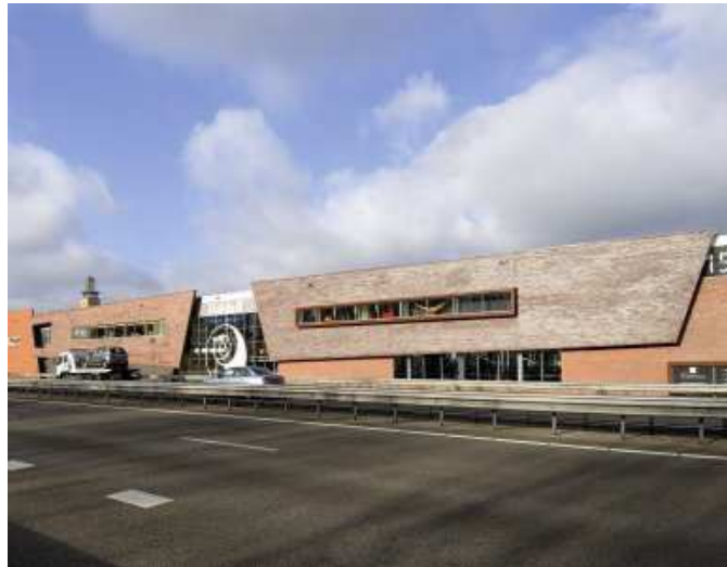
Figuur 11: Geluidwerende bebouwing langs de A4
