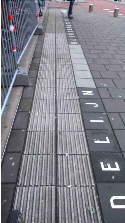
Foto 4.2.4: De activeringsfaciliteit voor de normen over het stallen op/bij de blinde geleidelijn.
