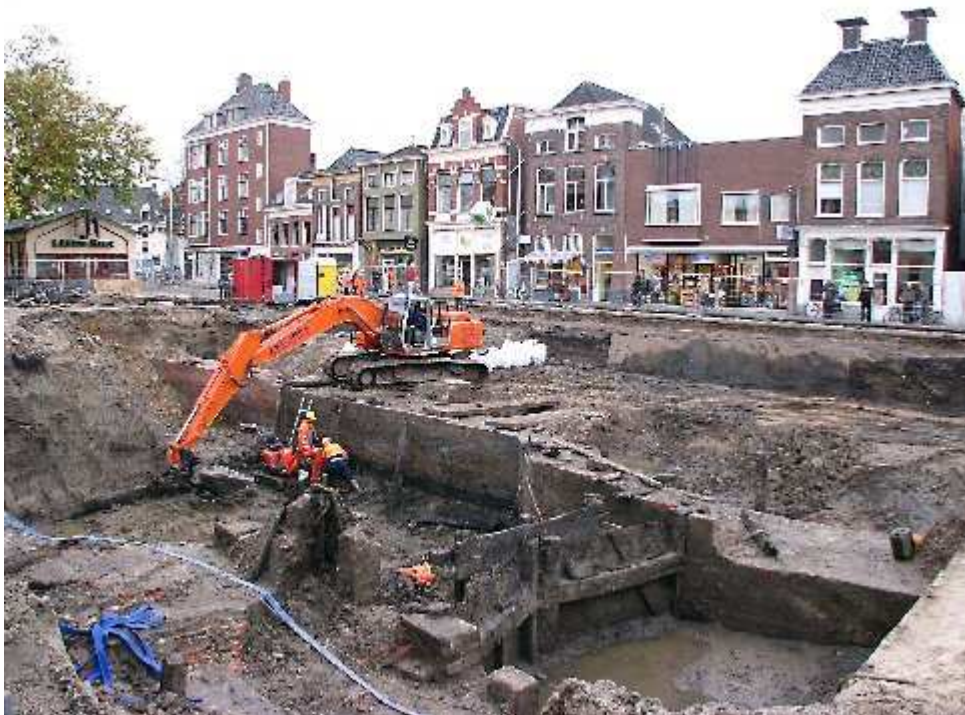
Figuur 1: De sluisdeur in het Damsterdiep wordt blootgelegd. (Foto: Gemeente Groningen)
