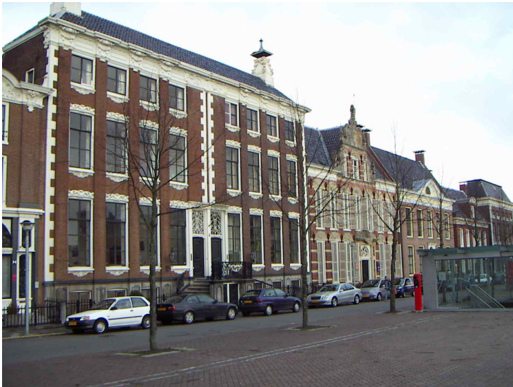
Figuur 2.4 Noordwand van de Ossenmarkt (10)
