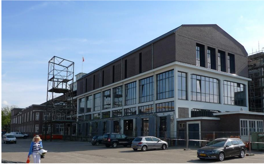
De opgeknapte Graansilo, een Rijksmonument
