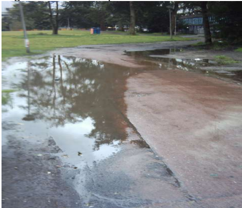
Figuur 6.9: Water op straat
